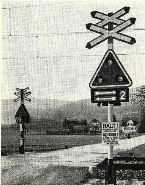
Bild 14 Blinklichtsignal an zweigleisiger Strecke
